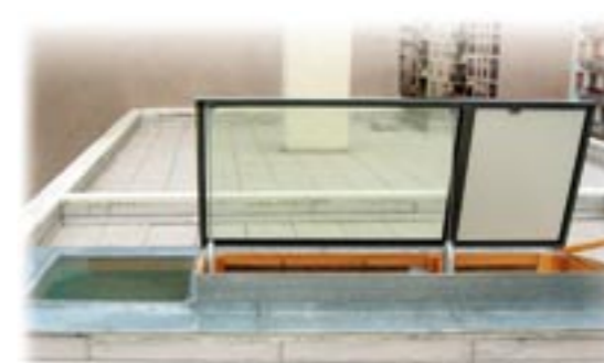
Dalle de verre (une partie fixe et une partie ouvrante à vérin électrique) avec accès à la terrasse
